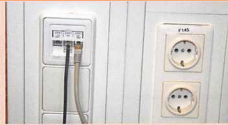
Netzwerk-Anschlussdose, TA
